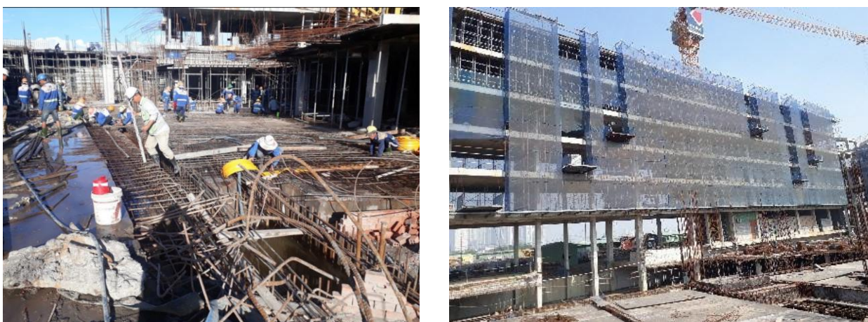
Lakeview 2: Khu 1 và 2 đang thi công xong phần khung thân.
