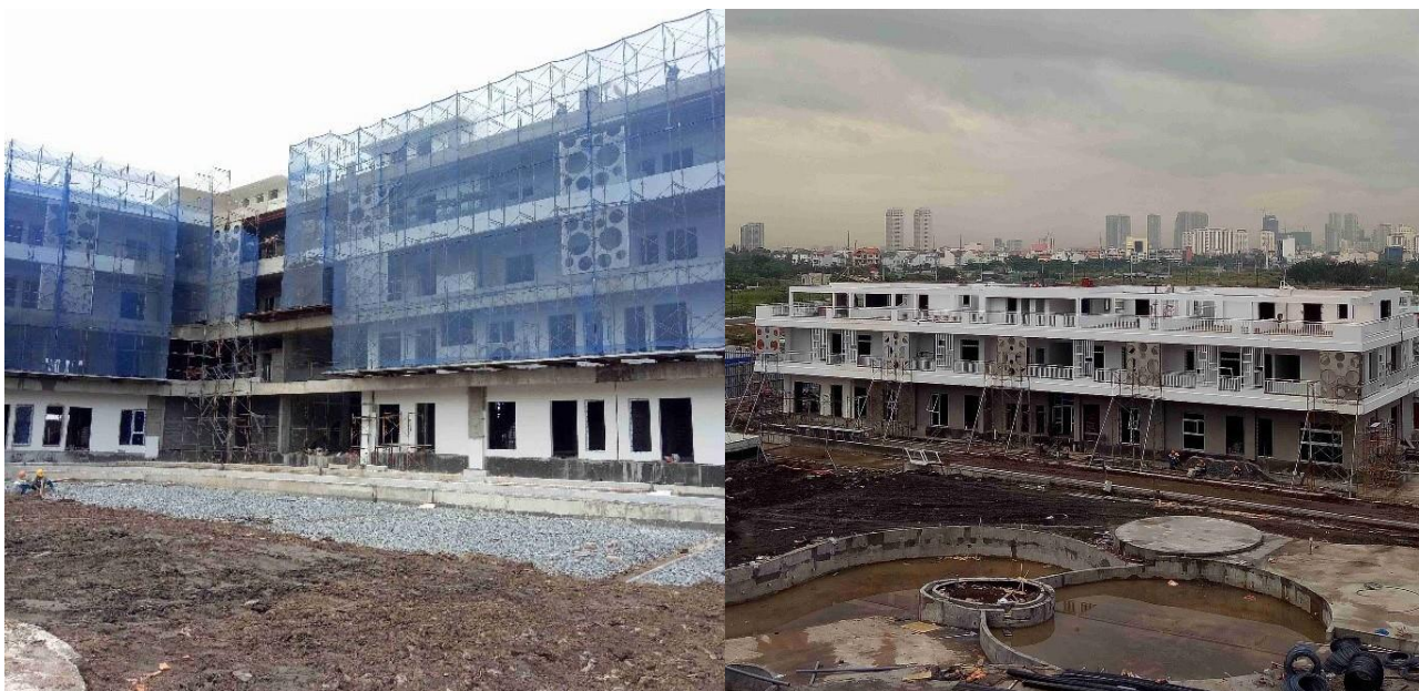
Lakeview 1: Khu nhà 4 tầng đã hoàn thành phần thô, đang thi công hoàn thiện
