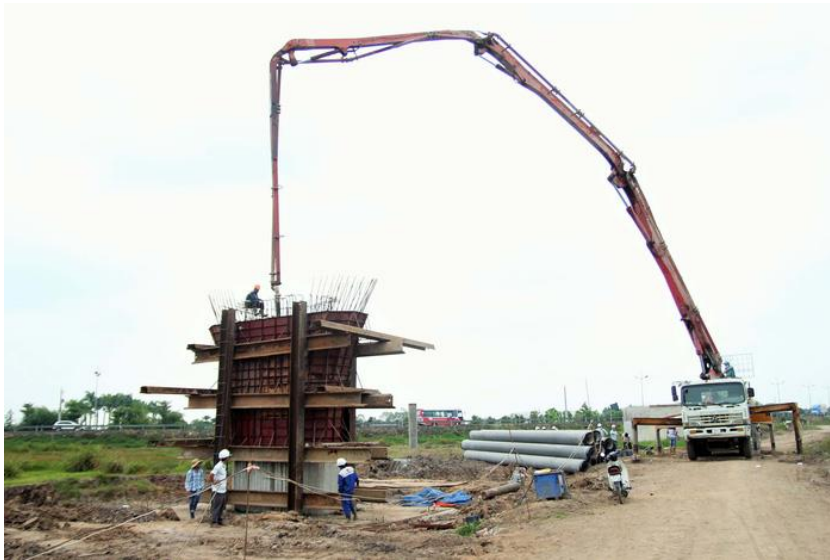
Dự Án Trung Lương – Mỹ Thuận đang thực hiện thi công
