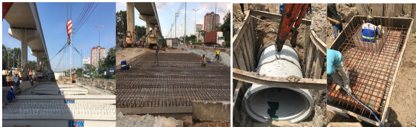
Dự Án Mở Rộng Xa Lộ Hà Nội: Thi công hệ thống thoát nước cống D2000 (đoạn từ đường Alexanderod đến đường Chu Văn An)
