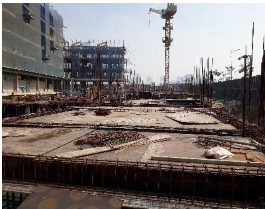
Lakeview 2: Khu 3 và 4 đang thi công lắp dựng cốt sàn tầng hầm
